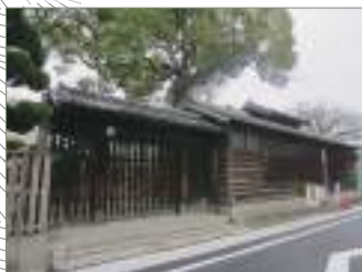
③ 旗屋小学校武家屋敷門
